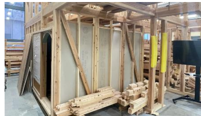
その6 令和6年1月現在（工事中）
