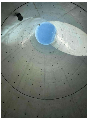
こども本の森 内部から撮影 青空が見えています
